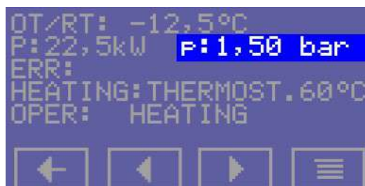
p: НАЛЯГАНЕ В ОТОПЛИТЕЛНАТА СИСТЕМА
